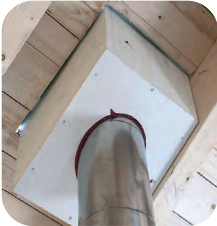
**Speziell für Dach- und Deckendurchführungen mit hohem Dachaufbau sowie bei abgehängten Decken:**
